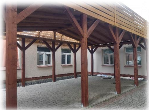
Budowa wiaty w celu zadaszenia „zielonej klasy”
