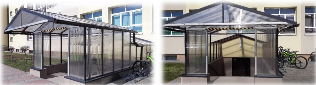
Wymiana poszycia dachu przy wejściu do szkoły od strony parkingu
